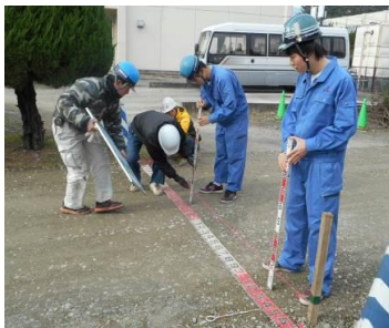
「施工現場での現場体験学」
