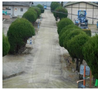
「舗装前の道路」
