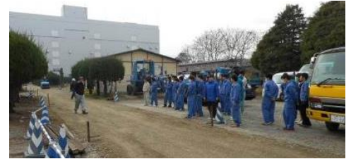
「施工現場の見学」
